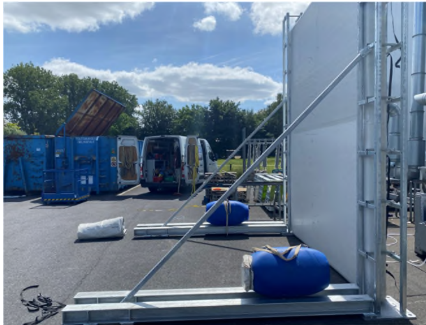
Abb. 5 : Exemplarischer Aufbau Cenotec mit Lagerschlitten. Alternativ Befestigung über Erdnägel
